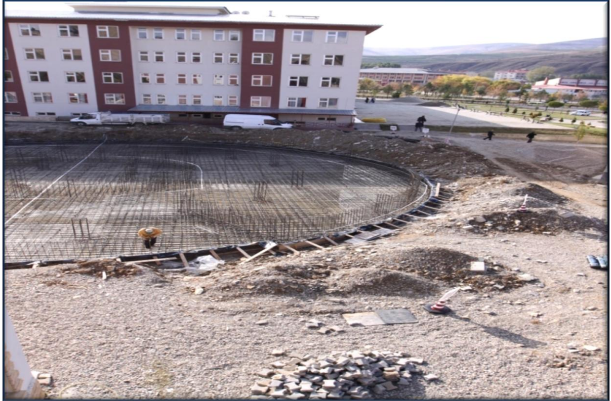
Resim14:Dede Korkut Kampüsü Kafeterya Yapım Çalışmasından Görünüm
